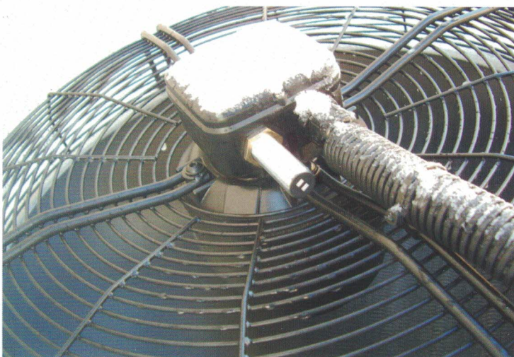
Eksempel: Udendørs ventilationsovervågning: med luftstrømsensor LG
