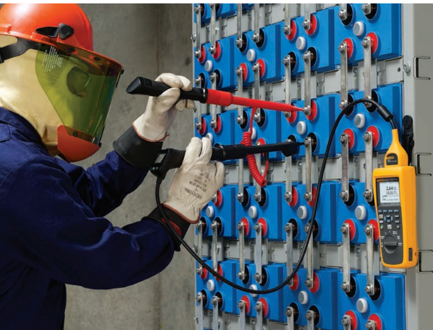
Måling av ohmske verdier i sekvensmodus
