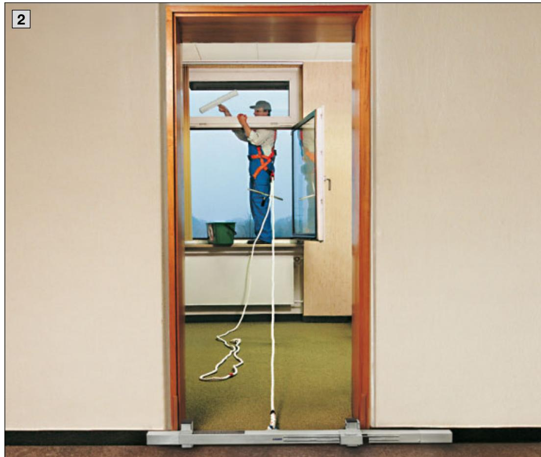
**1** Protection de deux personnes par une Traverse de sécurité placée dans une ouverture de porte jusqu'à une largeur maximale de 900 mm.
