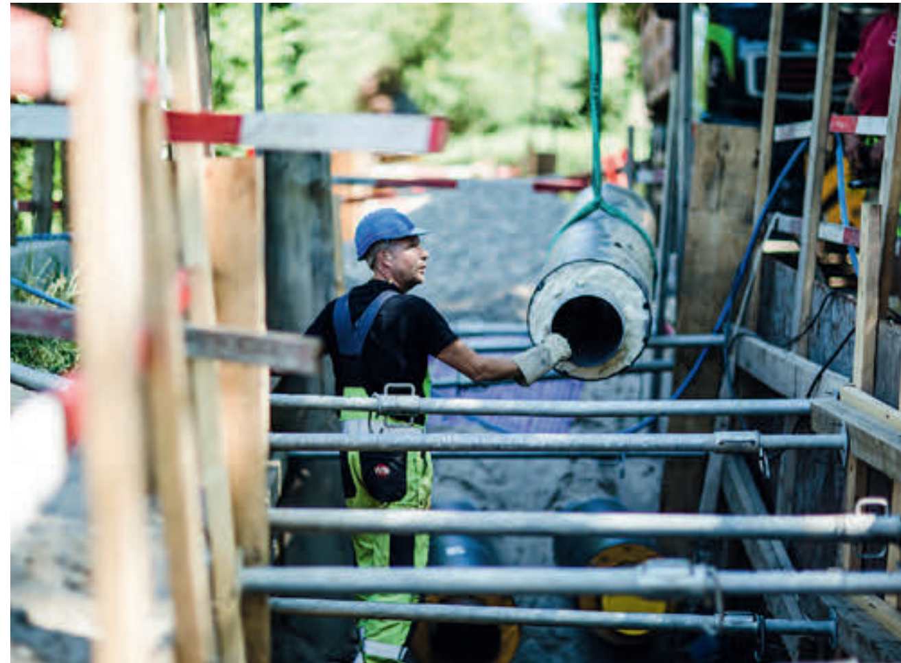
Foto: Fjernvarmerør i Køge, Wicotec Kirkebjerg A/S
