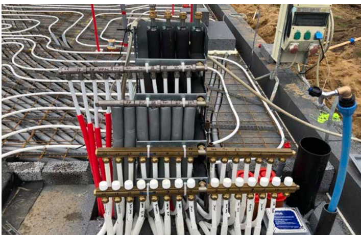
BUNDMODUL med: 15 gulvvarme-, 11 koldtands- og 8 varmtvandskredse
