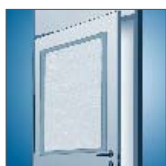
Vinduespanel i dør med 8 mm brudsikker glas
