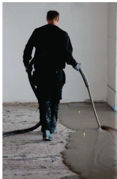
Opbygningen af undergulvet og brugen af materialer varierer efter, hvad gulvet skal bruges til. Foto: Saint-Gobain Denmark A/S – Weber.
