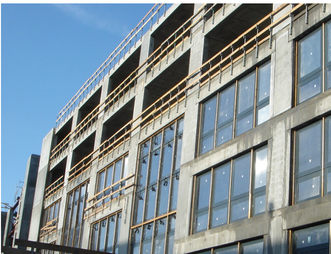
Fabriksfremstillede interimsvinduer har et lavere varmetab og kan bedre klare belastningerne i byggeperioden.
