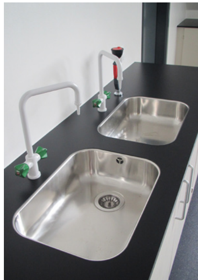
KEMIRESENTENT kompakt laminatbordplade med syrefaste vaske. Laboratorie armaturer og nødbruiser
