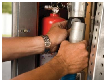
Anlægget starter automatisk når slangen monteres og stopper straks når slangen fjernes igen.
