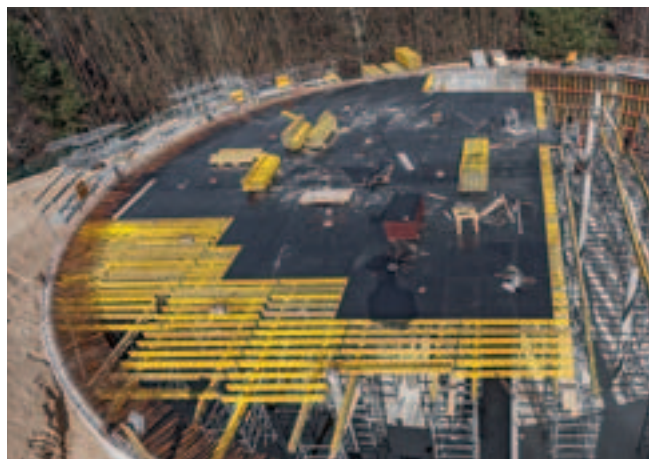
Som understøtningskonstruktion for GT 24 dobbelt rideplanke står 82 fritstående, op til 6,50 m høje MDS Støttetårne af PERI UP Flex Modulstilladssystem.
