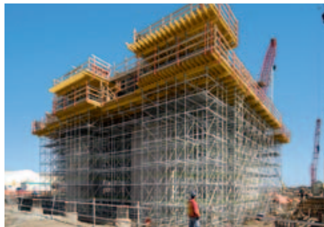
De høje laster fra den massive konstruktion blev pålideligt overført til jorden ved hjælp af PERI UP Rosett og MULTIFLEX i højder mellem 10 m og 12 m.
