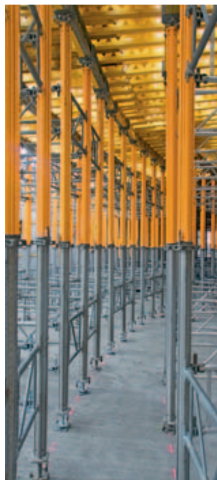
Det horizontale mellemliggende plan er designet med GT 24 gitterdrager som dobbelt rideplanke og strøer.
