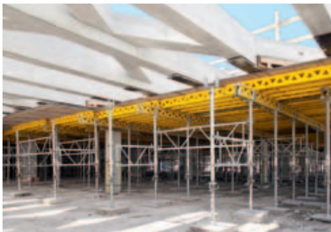
MULTIFLEX anvendes til fremstilling af in-situ beton bjælker med PEP støtterne forbundet med PEP Rammer PRK til opførelse af støttetårne.
