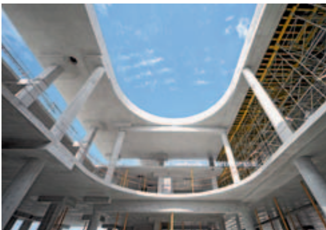
Det 30 cm tykke betondæk blev forskallet med MULTIFLEX.
