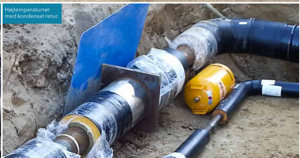
Isolerede højtemperaturforankringer.
