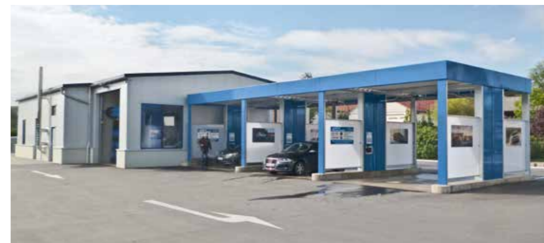
Kompakt stålkonstruktion: Den nok mest økonomiske løsning, enten med et fladtag eller med et buetag (et fladtag med et loftsrums). En kombination af portalvaskeanlæg og SB-vaskebåse.
