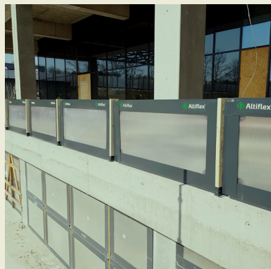
Sikkerhedsrækværk Udgør 30-40% af interimsaflukningen
