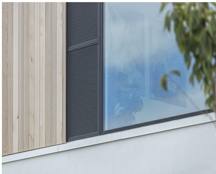
SPECIALLØSNING // NATURLIG VENTILATION
