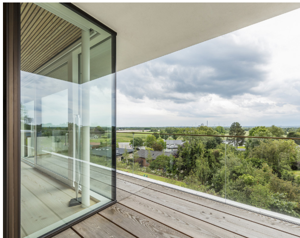
SPECIALLØSNING // GLASHJØRNER
