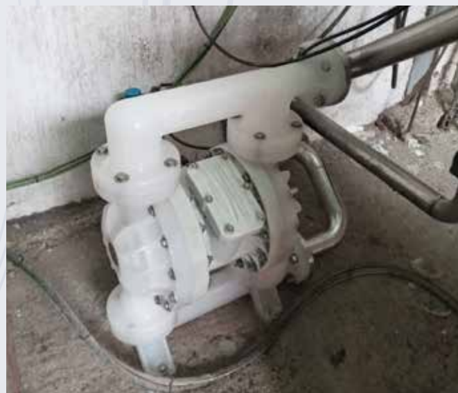
Hög vätskeviskositet minskar pumpens kapacitet.
