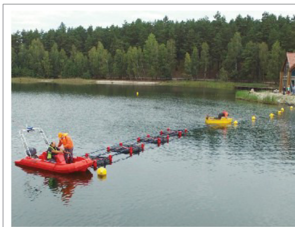
Sænkning af sø-varme elementer HURAKAN.
