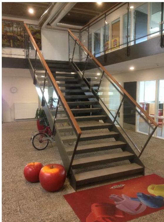
Billede 4: Ståltrappe og balkon med glasværn, fremstilling og montering - Hardi International Nørre Alslev.
