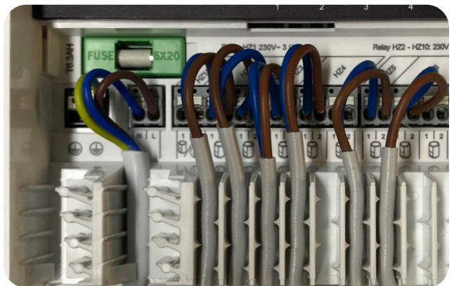
- telestaterne er ledningsført til styreboksen
