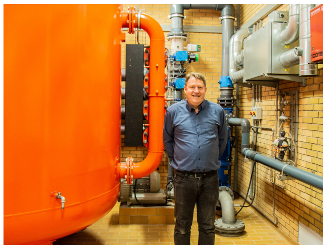
Vandværksbestyrer Steen S. Holm på Røde Kro Vandværk hvor råvandet filtreres og beluftes i lukkede tanke.
