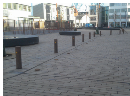
Pullerter og markeringssøm - Grønnegade, Odense
