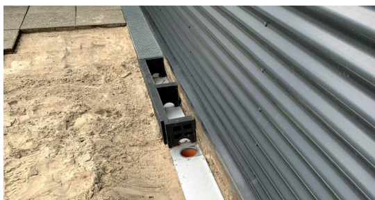
Bundplade og afløbselement lagt på afrettet underlag, derefter underdel og til sidst en rist.
