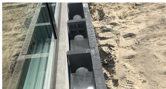
Underdelens buer sikrer at regnvandet frit løber til afløbselementet.
