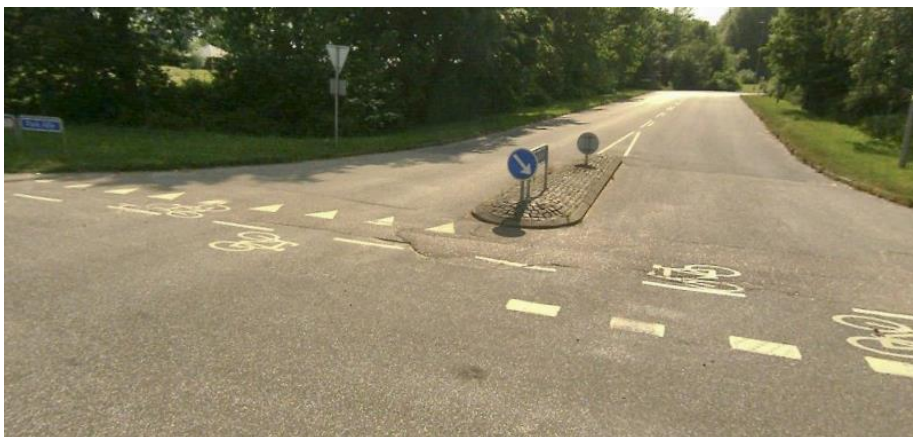
Figur 6 - Helleanlæg ved krydset mellem Pugdalvej og Park Allé set mod vest.
