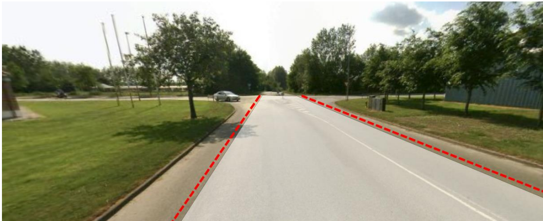
Figur 2 - Opbrydning af vejbelægning i Pugdalsej
