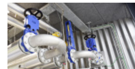
I rådnetanken recirkuleres slammet gennem en varmeveksler.
