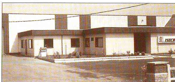
ISOCABs administrationsbygning og fabrik i Harelbeke-Bavikhove i 1975, Kervijnstraat
