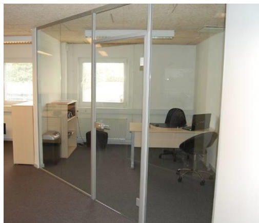
Glasdør i Clear alukarm med fast overglas.
