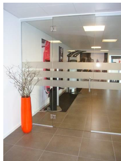
Glasdør uden karm med lukkefunktion i glashængsler.
