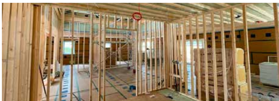
Foto af Snoezelhuset under byggeprocessen. Fotokreditering: Canbyg.
