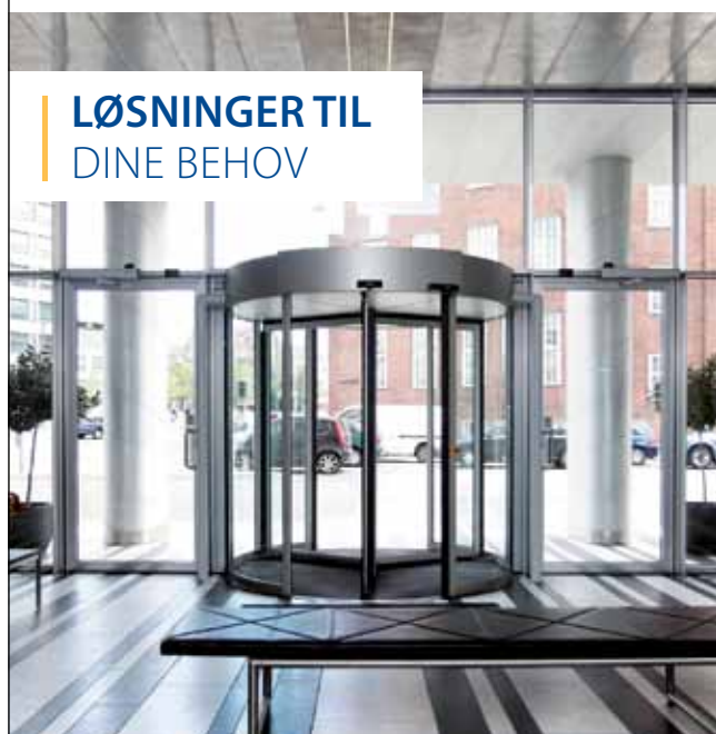
Ørstedhus indgangsparti: Glasfacade med aluminium og glassdøre - leveret af HS Hansen, 3 fløjlet karruseldør TSA 325 NT A3 med automatiske natdøre samt 2 stk. automatiske døråbnere Slimdrive EMD-F - leveret og monteret af GEZE.
