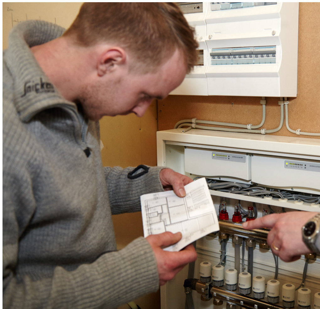
Teknikskabet er udført, så det kan monteres helt nøjagtig til Dennis Granhøjs projekt. Udførlig vejledning med beskrivelser har sikret fejlfri tilslutning af varmeslangerne.
