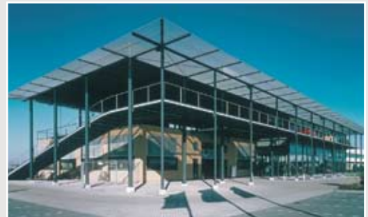
Solavskjerming og ramper, BMW, Woerden.
