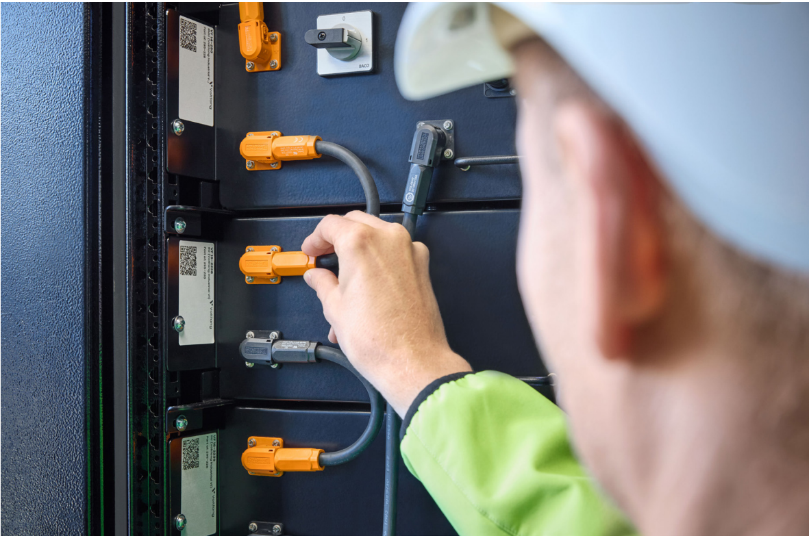
Batteripolstik fra Phoenix Contact anvendes også i energilagringssystemet
