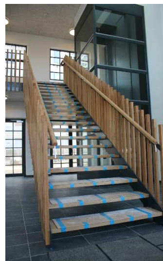
Billede 11: Ståltrappe med repos på 1. sal samt massivt egetræs værn og trin. Leveret og monteret i Søborg.
