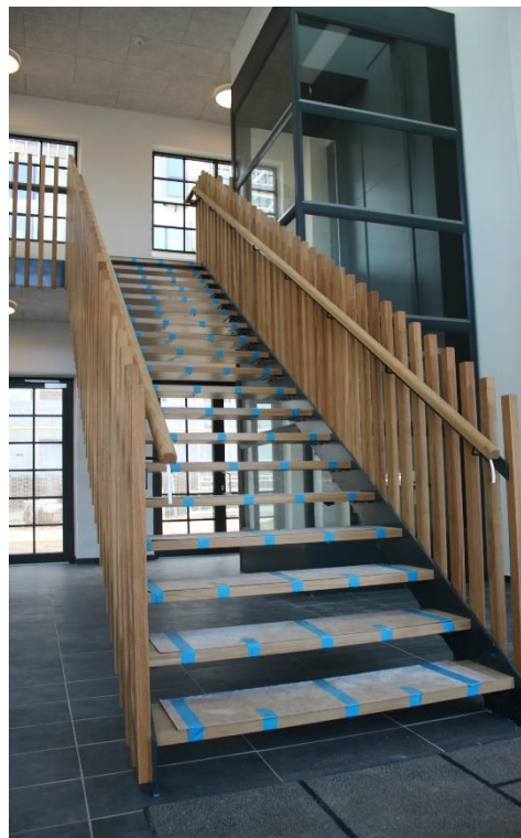
Billede 4: Ståltrappe og balkon med massive egetræs stave, fremstilling og montering - Kontorbygning København.
