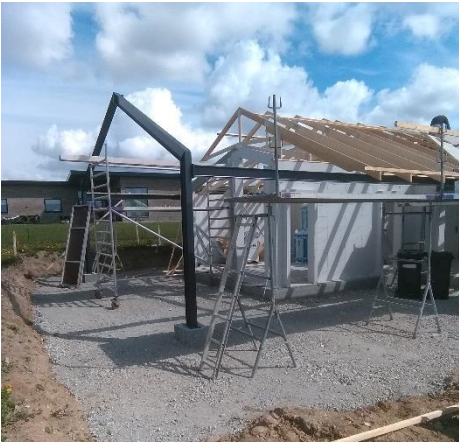
Billede 1: Stålkonstruktion og spær til byggeri, certificeret efter EN1090.
