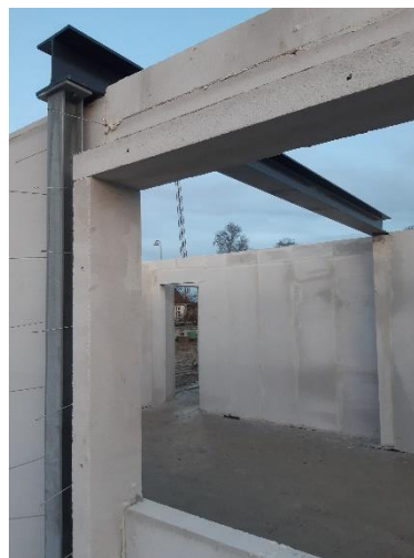
Billede 8: Galv. søjler og stålbjælker korrosionskategori C3 monteret i Køge.
