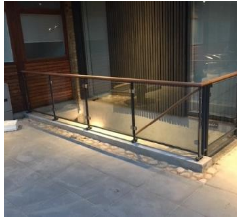
Billede 2: Stål låge og værn med glas og håndliste i mahogni. Leveret og monteret for Arkitekt i Farum.
