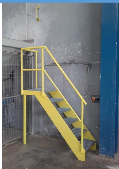
Billede 7: Industritrappe varmgalvaniseret og malet i signal gul.
