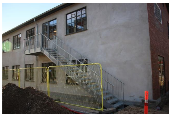
Billede 6: Galvaniseret ståltrappe med repos. Leveret og monteret København.
