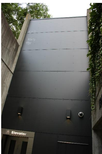
Billede 10: Rustfri og sort facadebeklædning - Birkerød Station.
