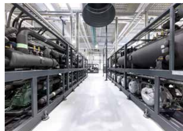
C-300 chiller (med varmegenvinding) til køling af maskin- og transformerrum
