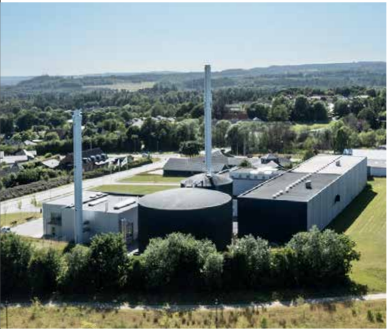
Det oprindelige Ry Varmeværk udvidet med akkumuleringsstanke
