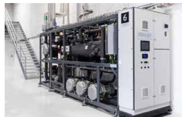
C-300 chiller (med varmegenvinding) til køling af maskin- og transformerrum
