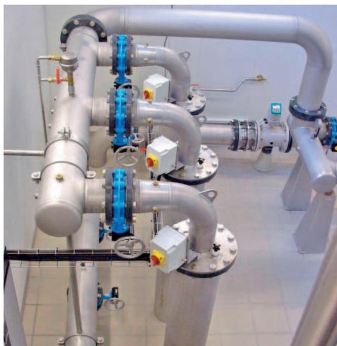
für notwendigen Komponenten wie Rohre, Pumpen und Armaturen sind aus hochwertigem Edelstahl gefertigt.
