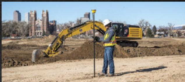
**Trimble Siteworks positioneringsystem til landmålere** består af Trimble SPS986 eller SPS785 GNSS smartantenne, TSC7 håndholdt controller eller T7 tablet og Siteworks-software. Landmålere kan nu arbejde med komplekse 3D-modeller, indsamle store datasæt hurtigere, nemmere visualisere komplekse 3D-modeller og arbejde mere effektivt dag eller nat.
