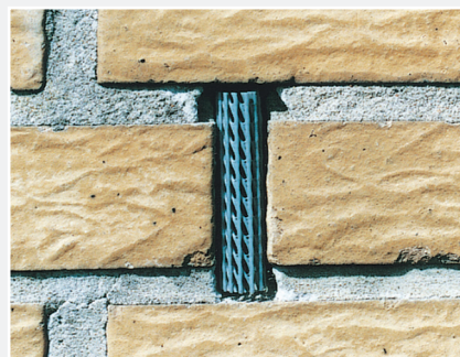
Studsugerør monteret i mur
