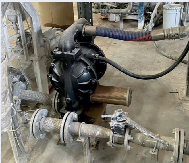
Hög sughöjd minskar pumpens kapacitet.
