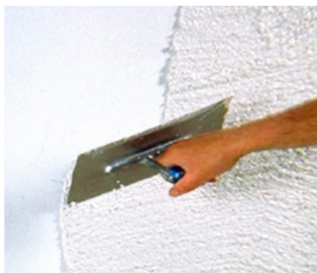
Påfør slutpudsproduktet så tyndt som muligt med en rustfri stålspartel.
