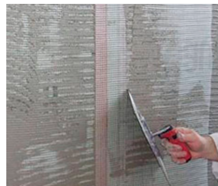
Næste bane armeringsnet lægges i Baumit ProContact DC 56-laget og udjævnes. Nettet skal overlappe min. 100 mm i alle samlinger. Nettet skal ligge i den yderste \frac{1}{3} del af Baumit ProContact DC 56-laget for at undgå revner. Til sidst glattes overfladen så godt som muligt med en bred stålspartel.
