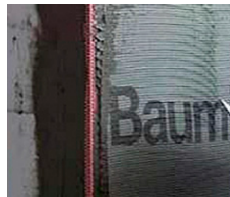
Armeringsnettet afsluttes 30 mm fra hjørner.
