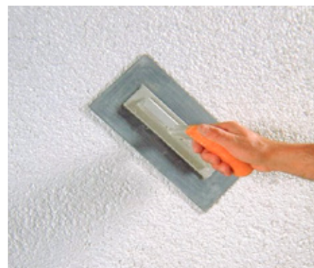
Kunststofbræt anvendes til at køre slutpudsproduktet sammen "vådt i vådt" i små hurtige cirkulære bevægelser.
