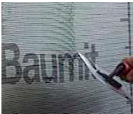
Nettet glittes let ind i Baumit ProContact DC 56 med et stålbræt fra midten og udad for at undgå krøller.
