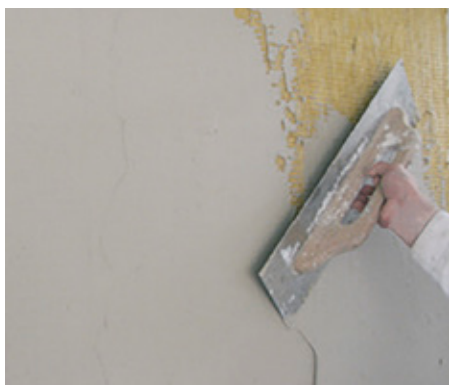
Der påføres et tyndt lag Baumit ProContact DC 56 som kontaktag.
