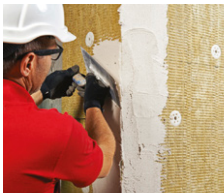
Påfør Baumit ProContact DC 56 ca. 150 mm ud fra hjørner med tandspartel.
