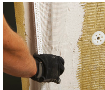
Monter hjørneprofil, som nu glittes ind i laget med Baumit ProContact DC 56 med et stålbræt.
