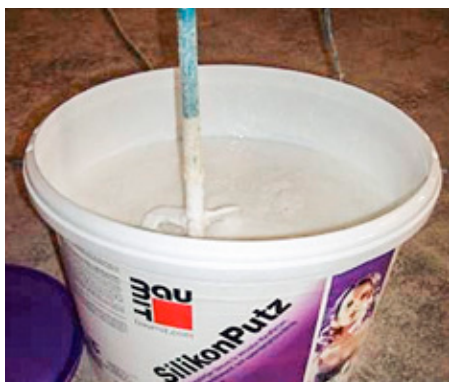
Omrør slutpudsproduktet med omrører.
