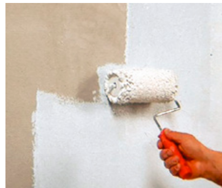
Påfør Baumit UniPrimer med malerrulle eller bred pensel. Skal tørre i min. 24 timer.
