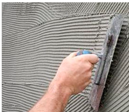
Størrelsen på tandspartlen bestemmer lagets tykkelse. 12 mm tandspartel giver ca. 6 mm tykkelse.
