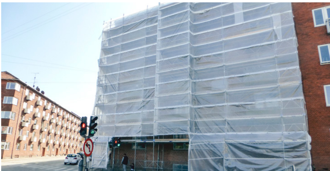
Beskyt færdigpudset facade indtil den er helt tør. Dette varer 2-3 dage ved optimale vejrforhold.
