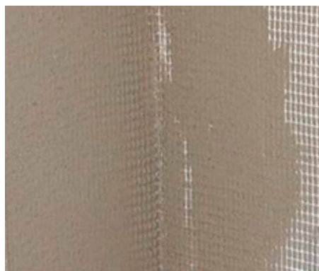
Ekstra armeringsnet 200 x 200 mm monteres i alle indvendige hjørner i Baumit ProContact DC 56.
