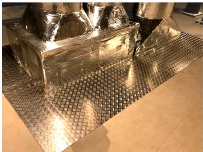
Brandlukning af ventilationsgennemføring i dæk, hvor brandlukningen er beskyttet mod personlast med dørklade.
