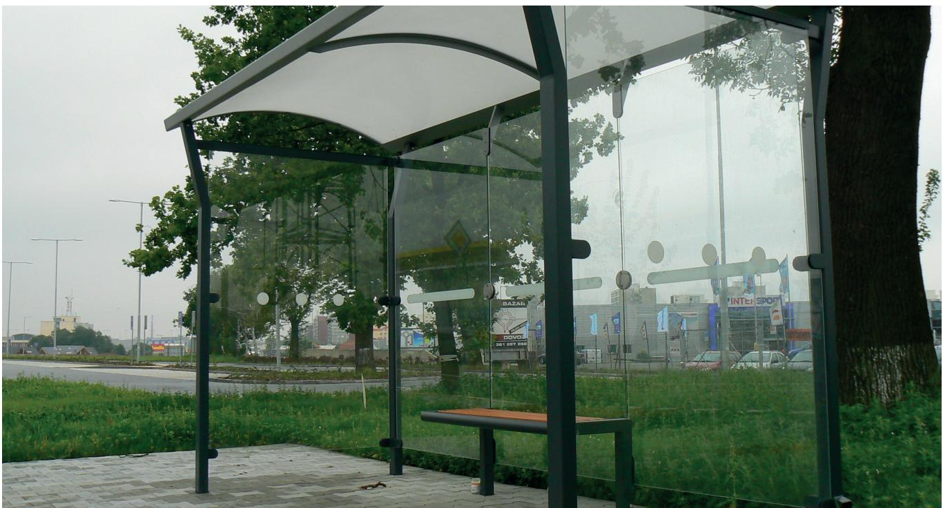
Polykarbonat er et transparent plastmateriale, og er karakterisert ved høy styrke, stivhet og hardhet. PC har høy slagstyrke og blir ofte betegnet som «uknuselig».
