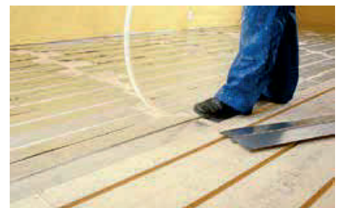
Varmerør lægges i sporene
