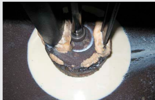
Eksempel på svamp i en pumpebrønd, som kræver handling for ikke at udvikle sig til et stort problem.
