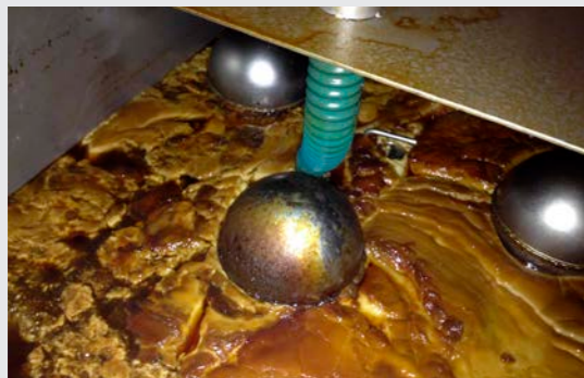
Eksempel på svamp i et centralt filteranlæg. Og samtidig et eksempel på meget dårlig opfølgning og vedligehold.
