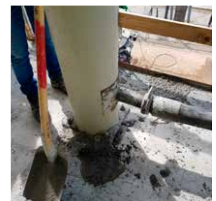
Komposit søjler pumpes og udstøbes fra bunden.
