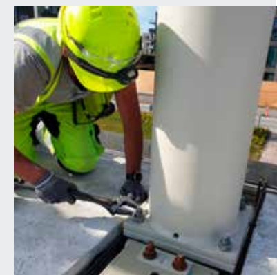
Montage af komposit søjler og DELTABEAM® ved hjælp af boltede samlinger.
