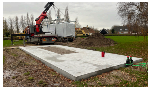
Levering på site. CC-varmpumpen bliver her installeret på et betonfundament.
