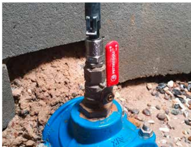
Tryksensorer kan installeres på kritiske punkter i distributionsnetværket takket være batteridrift og IoT-kommunikation.
