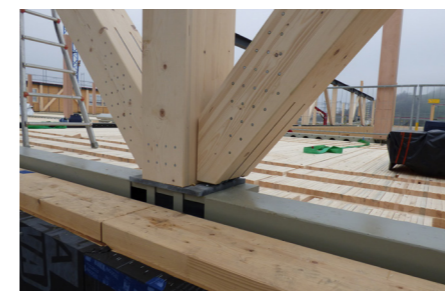
Samling mellem vindkryds, søjle i træ og DELTA BEAM®
