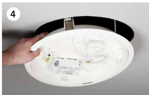
4 Træk ledningerne ind i armaturet, og frigør de tre låsefjedre. Armaturet installeres i hullet.
