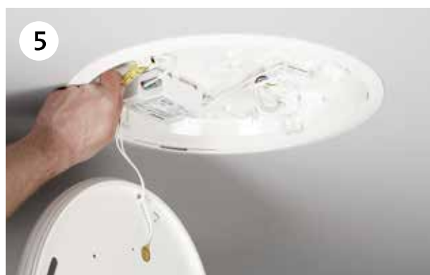
5 Fastgør sikkerhedslinen, og især lynkoblingen. Monter lyspakken i armaturhuset med en bajonetlås.
