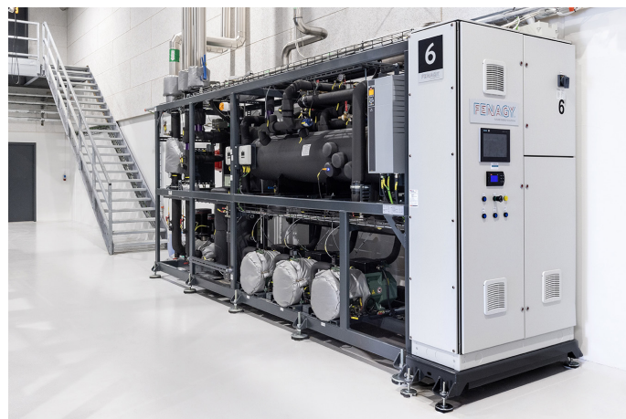
C-300 chiller (med varmegenvinding) til køling af maskin- og transformerrum
