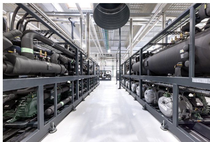
C-300 chiller (med varmegenvinding) til køling af maskin- og transformerrum
