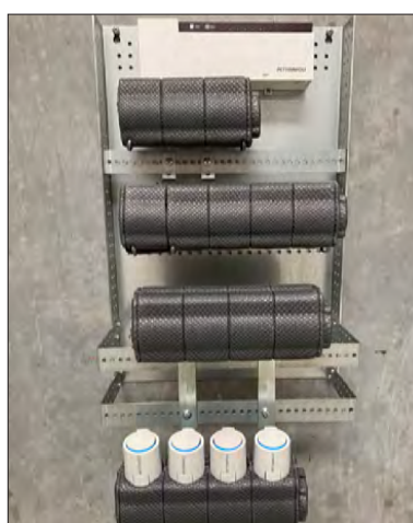
Skaktløsning med ekstra tilbehør: gulvvarmestyring og telestater.
