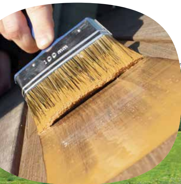
Foto: Nylagt og nyolieret Jatoba terrasse
