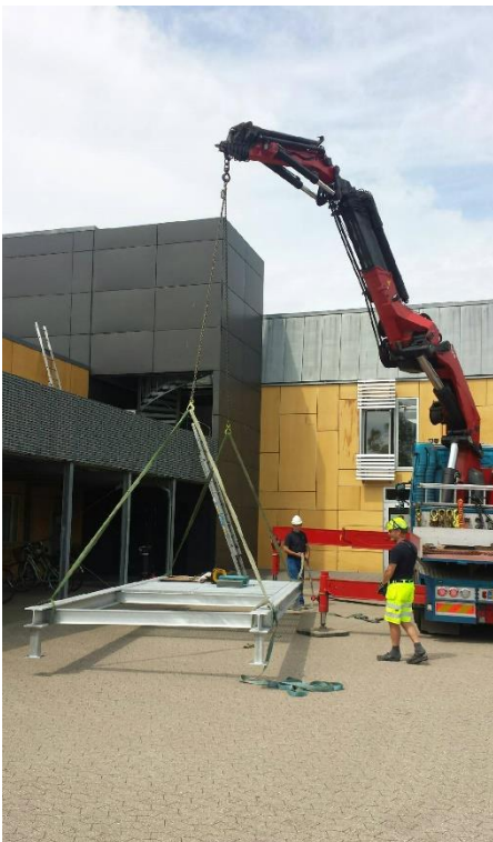
Billede 3: Fremstilling og montering af stålramme - Retten Helsingør.
